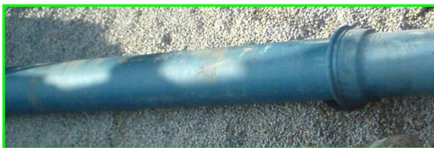
Pose sur pierres ou tous autres points durs à proscrire absolument
