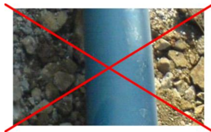
Pose sur pierres ou tous autres points durs à proscrire absolument
