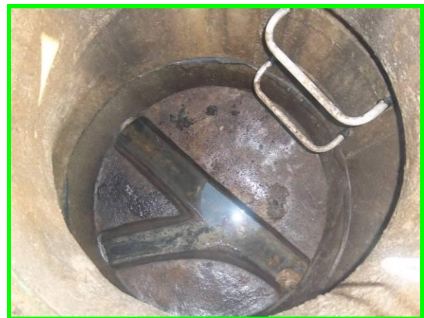
Fond de regard aménagé en cunette : écoulement satisfaisant
