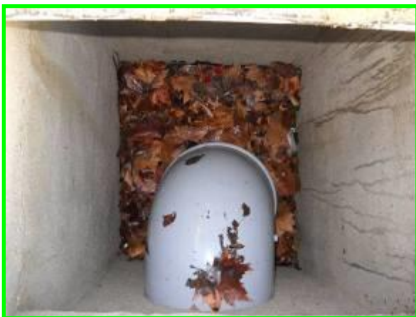
Avaloir de 700 x 700 mm intérieur : Dimensions correctes, entretien possible
