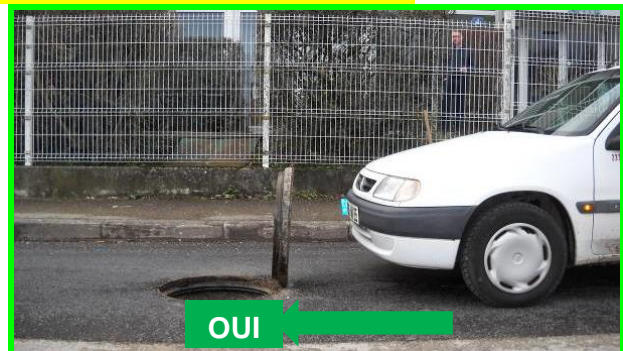
Charnière côté amont du sens de circulation
