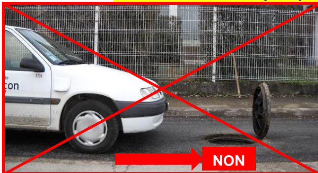
Charnière côté aval du sens de circulation
