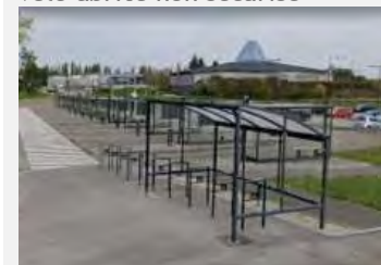
Pôle Micropolis - stationnement vélo abrité non sécurisé
