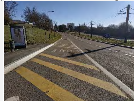
Site propre - Boulevard Alexandre Fleming à Besançon
