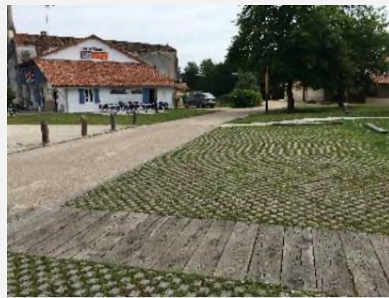
Exemple de parking végétalisé (Source : Explain)
