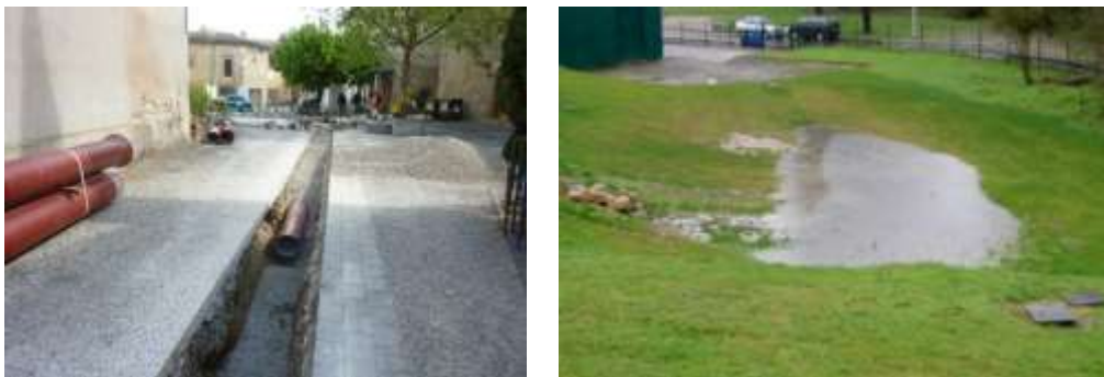
Exemples de modes de gestion des eaux pluviales opposés : à gauche, des canalisations coûteuses et à fort impact environnemental, à droite une gestion sobre et économique
